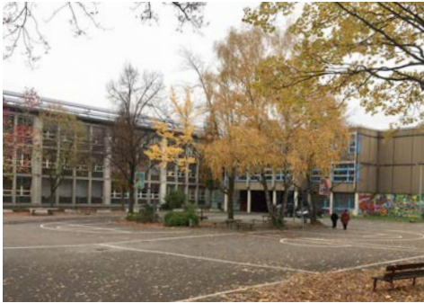
Neubau Frida Levy Gesamtschule, Essen 2021-2023
