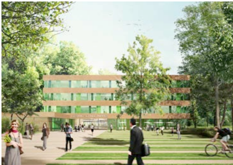
Neubau Gesamtschule Nippes, Köln 2012
